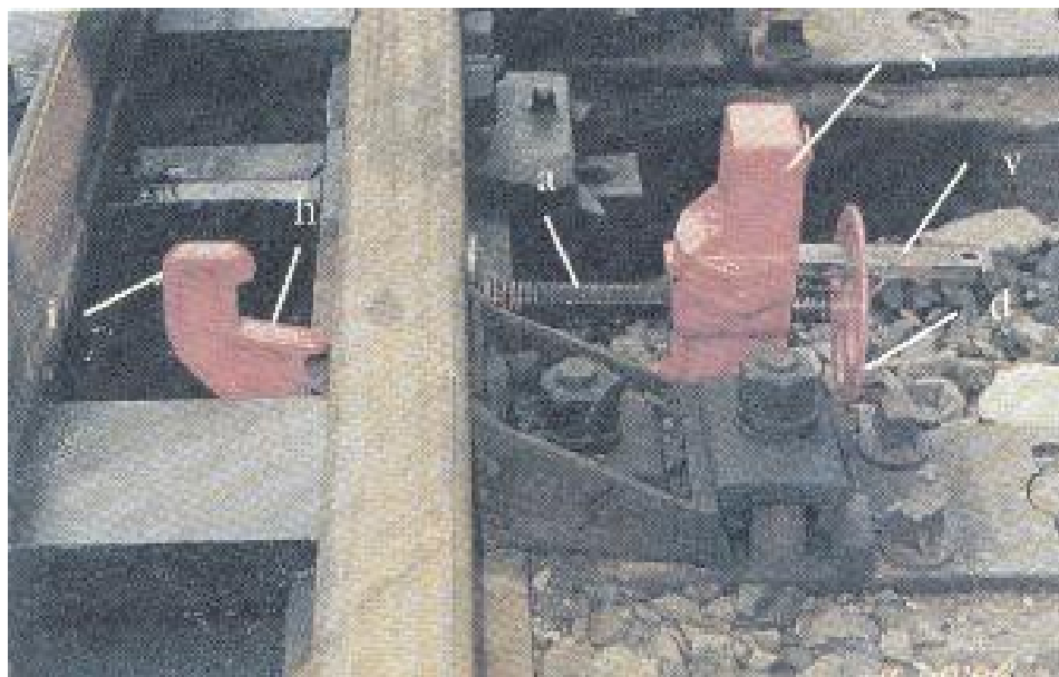
Rys.1. Zabezpieczenie iglicy odsuniętej.
