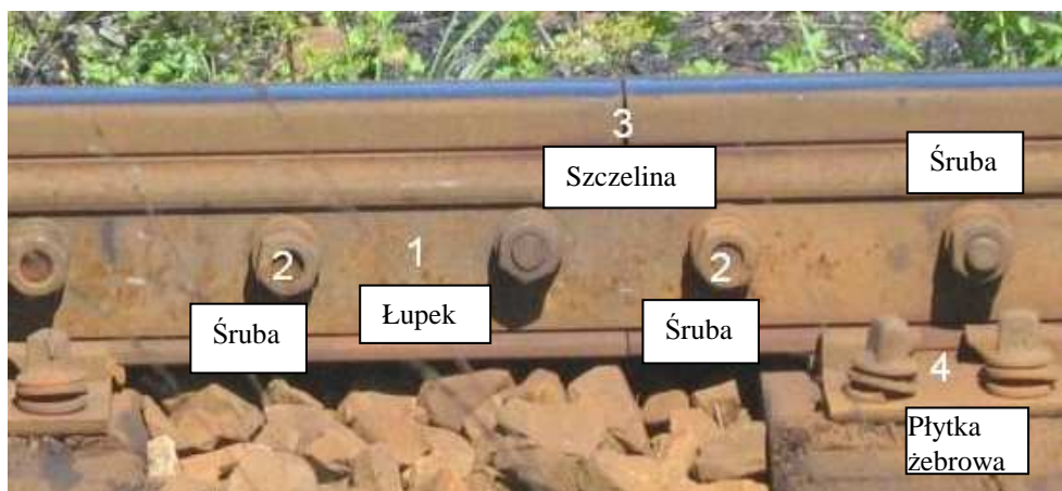
Rys. 19. Złącze wiszące szyn [materiał własny]
